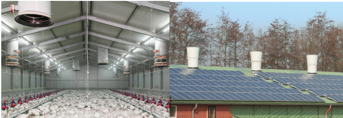
Slika: Vertikalni prezračevalni jaški za prezračevanje
