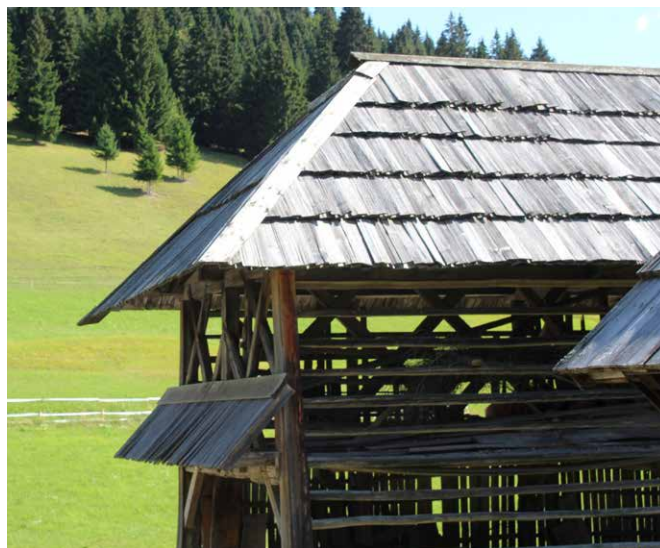
S skodlami pokrit kozolec s čopi, ki pa niso običajni za strehe na Bohinjskem. Ta jih ima, ker so s tem zmanjšali vpliv vetrov, ki na tem mestu v Koprivniku nad Bohinjem stalno pihajo.
